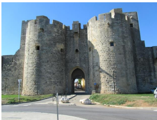
La porte de la Reine, côté campagne © Centre des Monuments Nationaux
