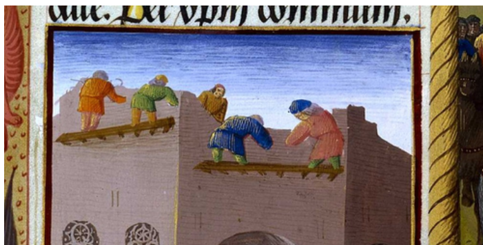
22. Échafaudage seulement constitué de planches posées sur des poutres ancrées dans le mur
