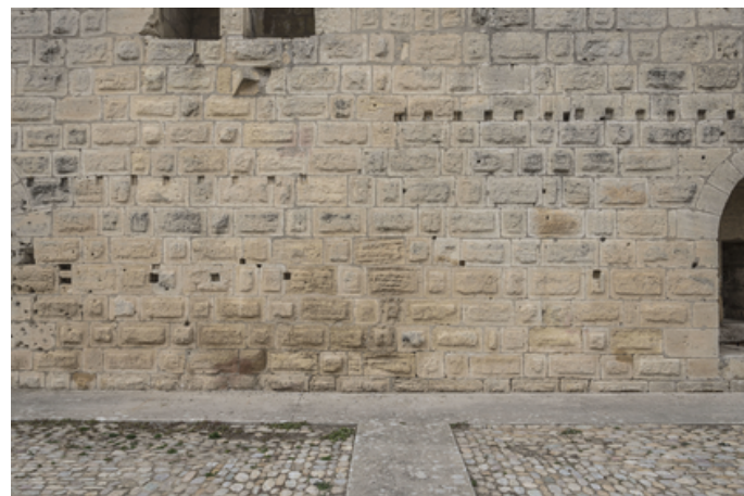
12. Tours et remparts d'Aigues-Mortes, courtine du front nord
