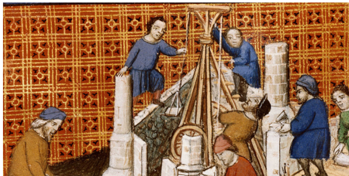
21. Des échafaudages de bois et de corse et une chèvre à trois pieds
