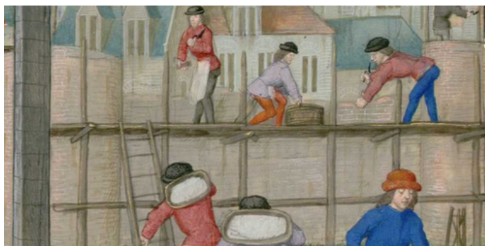
23. Échafaudage dit "à pied" et à "un rang de perches"
