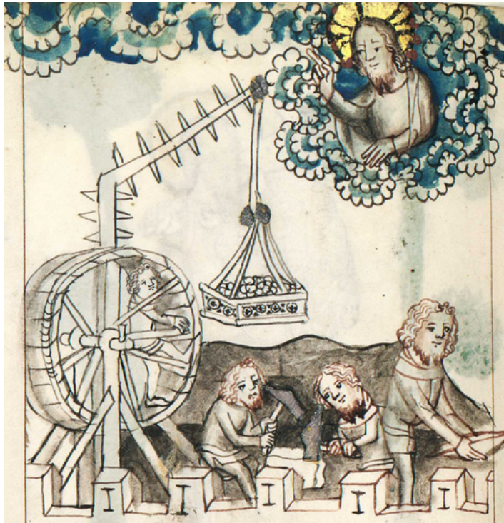
28. La grue à cage écureuil
