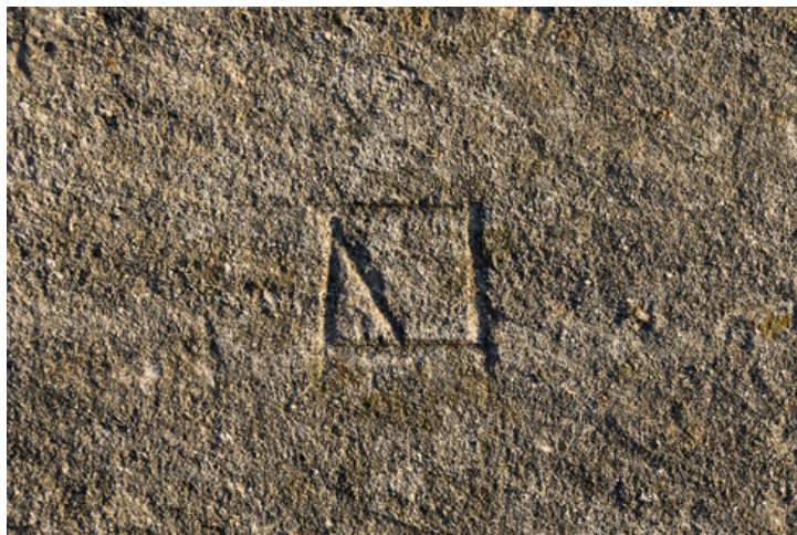
10. Tours et remparts d'Aigues-Mortes, signe lapidaire
