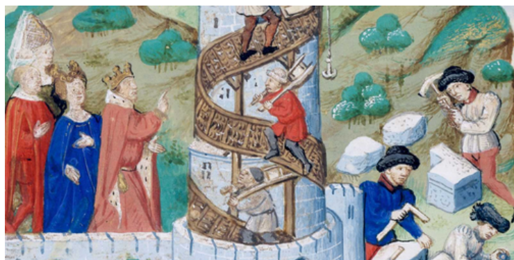
o6. Tailleurs de pierre et maçons
