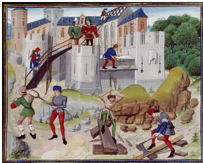
25. Le mortelier remplit l'oiseau qu'un manoeuvre porte sur son dos avec une pelle en bois
