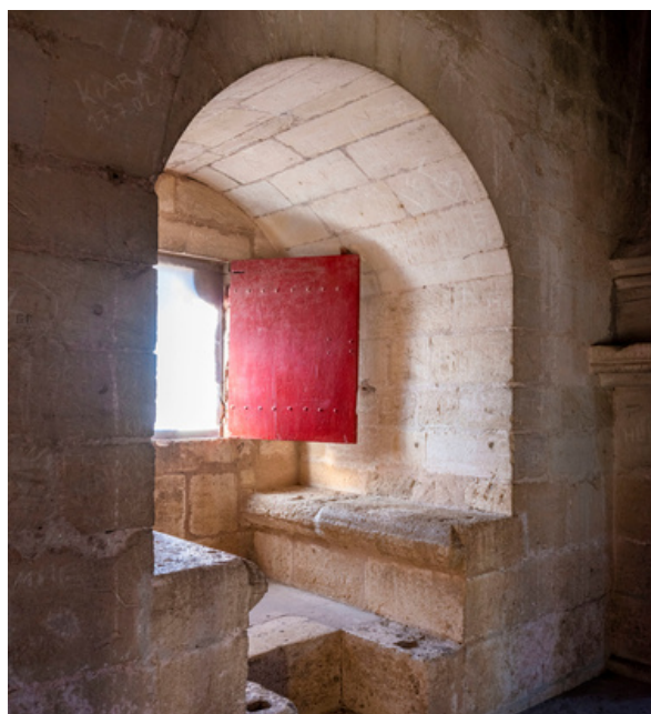
05. Chambre de tir - tour du Sel
