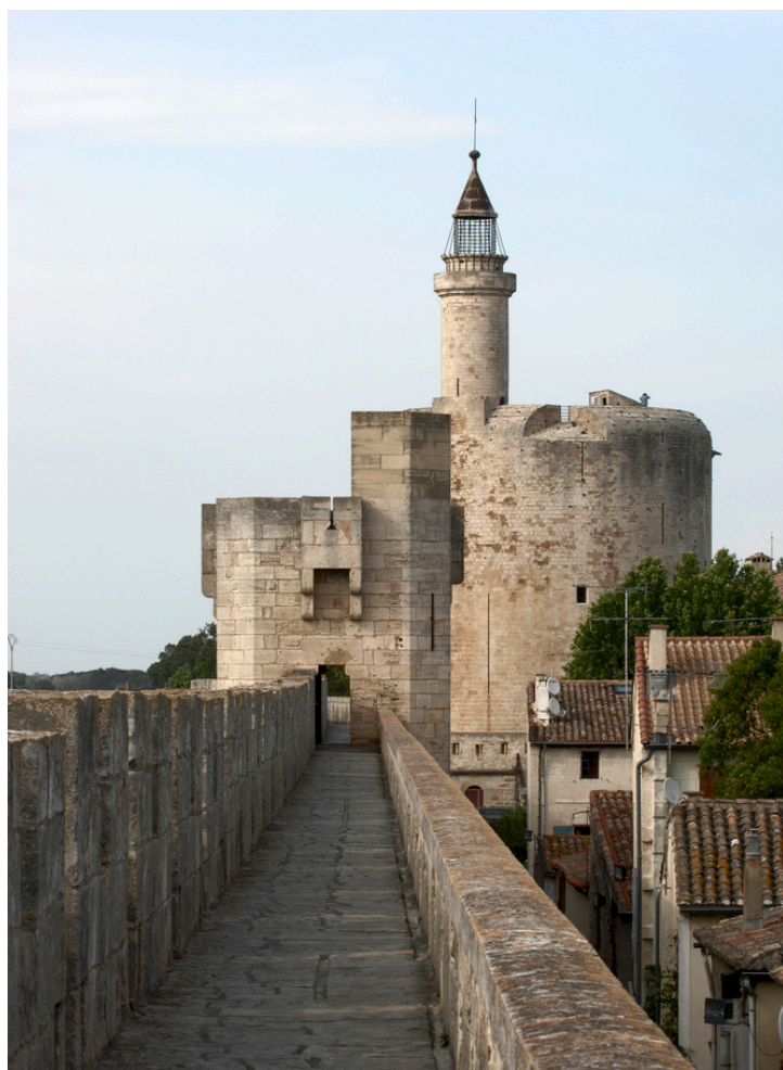
01. Vue sur la porte des Remblais et la Tour de Constance depuis la courtine.
