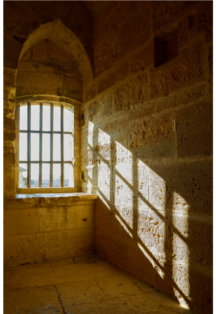
12. Salle haute de la Tour de Constance, vestibule.
