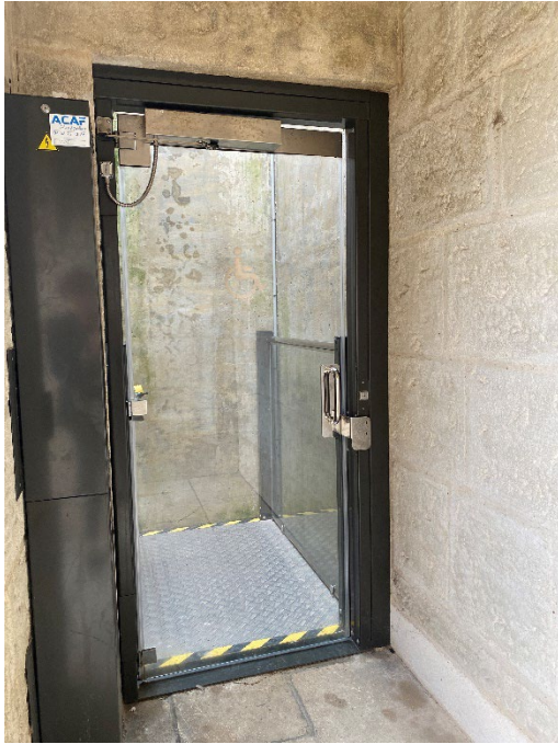
Légende : vue extérieure sur l'entrée de l'élévateur qui assure la liaison avec le chemin de ronde.
